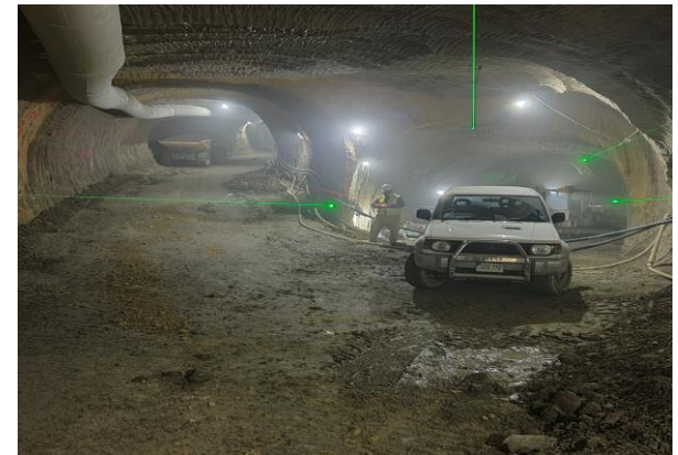
Pembroke - Ta Qali tunnel
