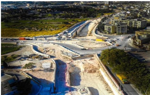
Sta Lucija Underpass
