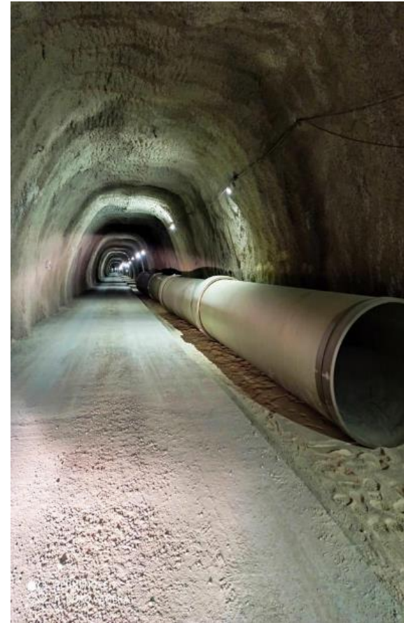
Pembroke – Ta' Qali tunnel
